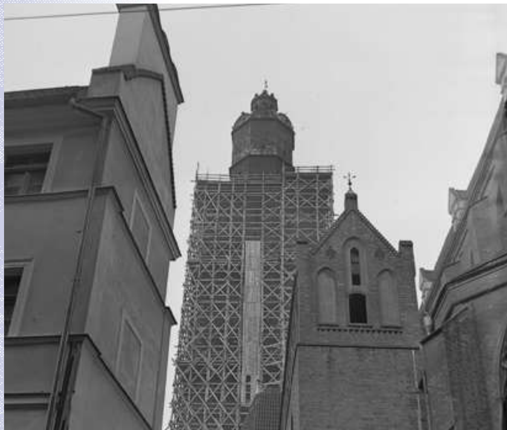
Kościół garnizonowy św. Elżbiety w trakcie renowacji, styczeń 1975 r. Fot. Stanisław Kokurewicz / Ośrodek „Pamięć i Przyszłość”
